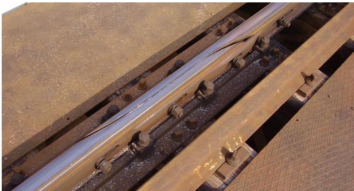
12. ábra: Csilléry féle dilatációs szerkezet
