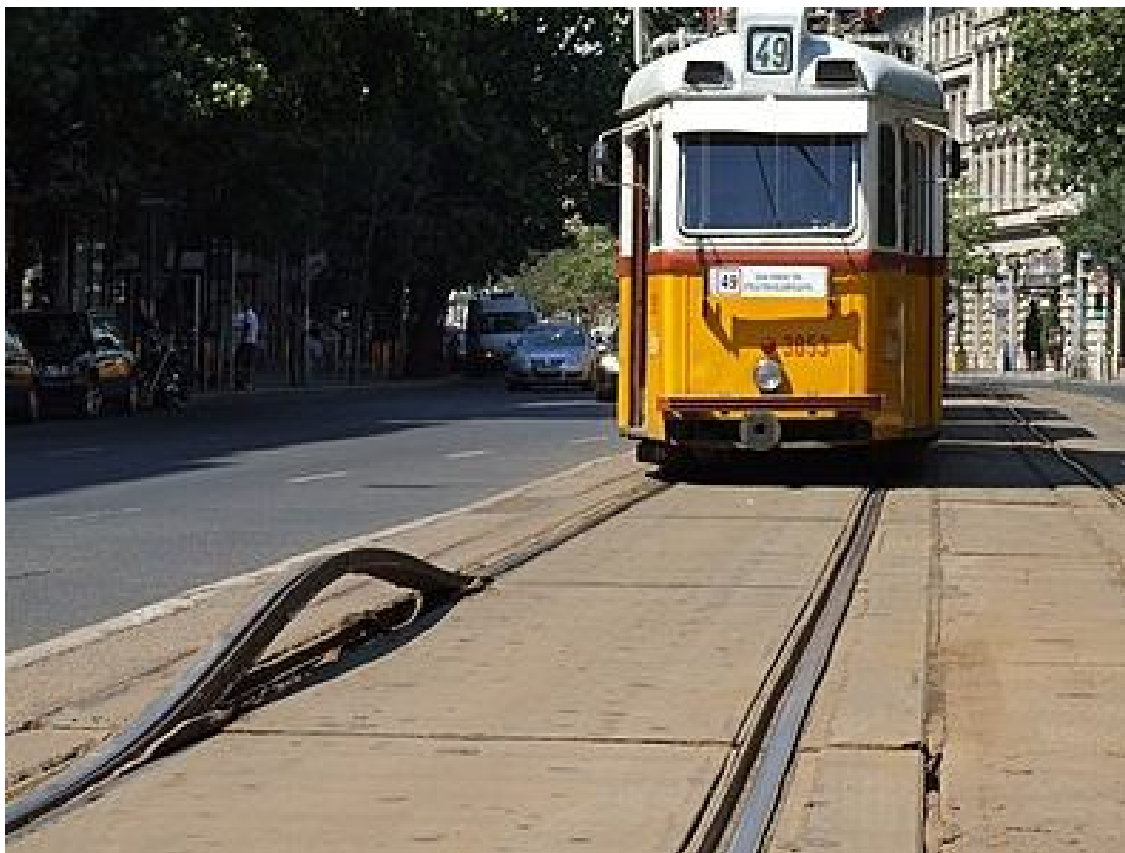
25. ábra: Függőleges vágánykivetődés
