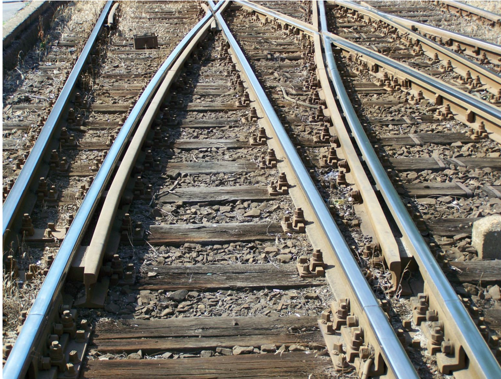
50. ábra: Terelősínes felépítmény
