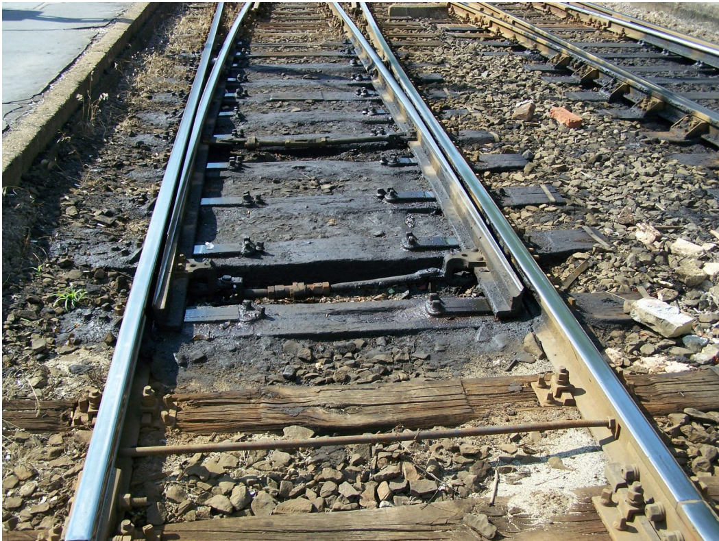
38. ábra: Utánjáró váltó
