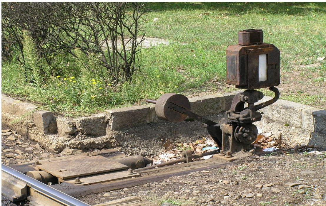
41. ábra: Kézi állítású ellensúlyos váltó
