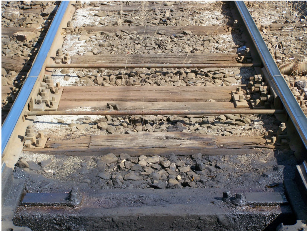
24. ábra: Nyomtávtartó rudak
