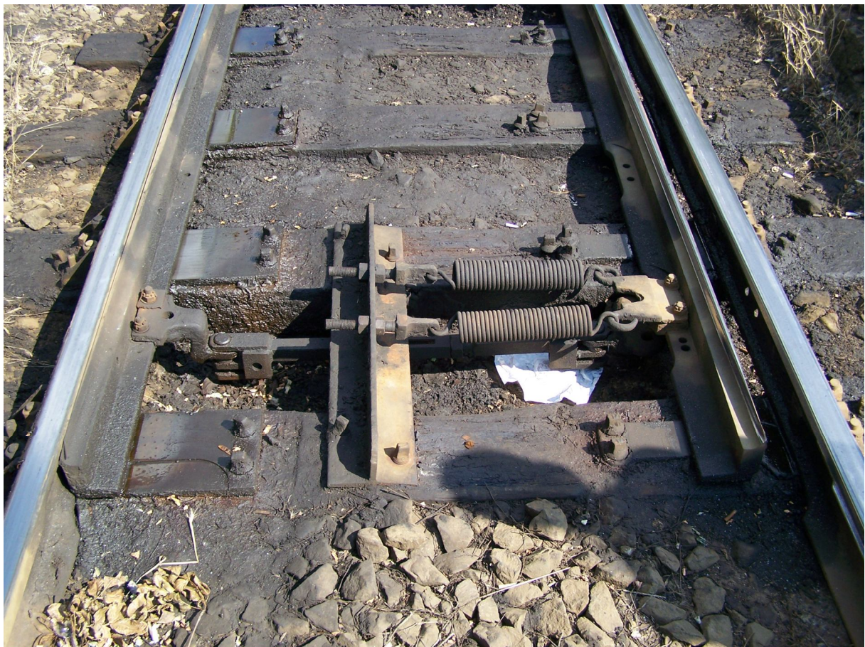
39. ábra: Rugós visszacsapó váltó
