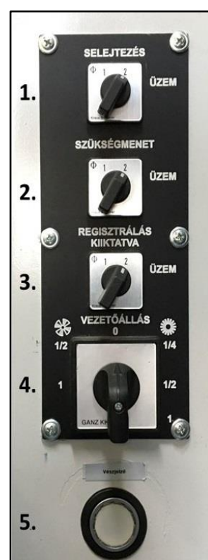
23. ábra A vezetőfülke oszloppanel kapcsolói
