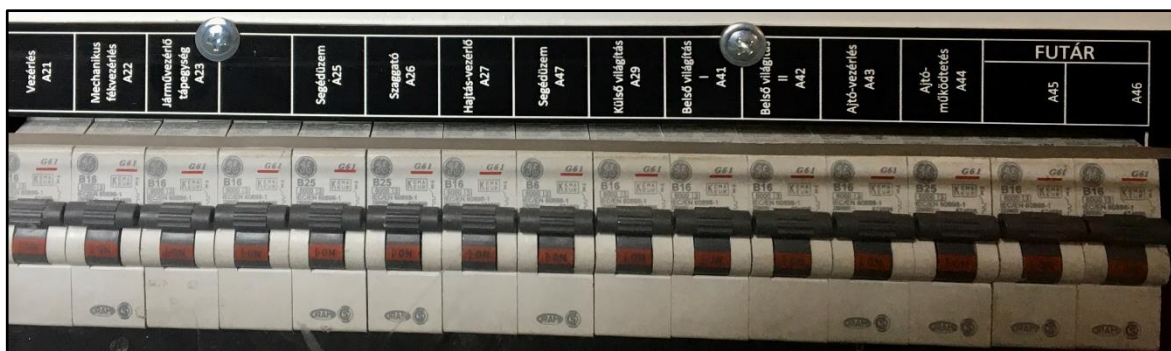
21. ábra Kisautomaták a jobb oldali készülékszekrényben
