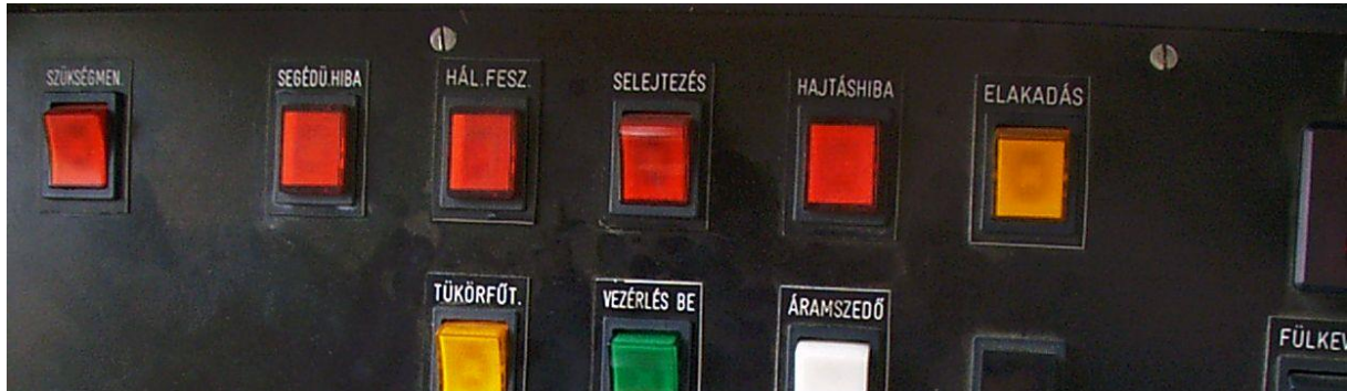
12. ábra: Hibajelzések és szükségüzem kapcsolók
